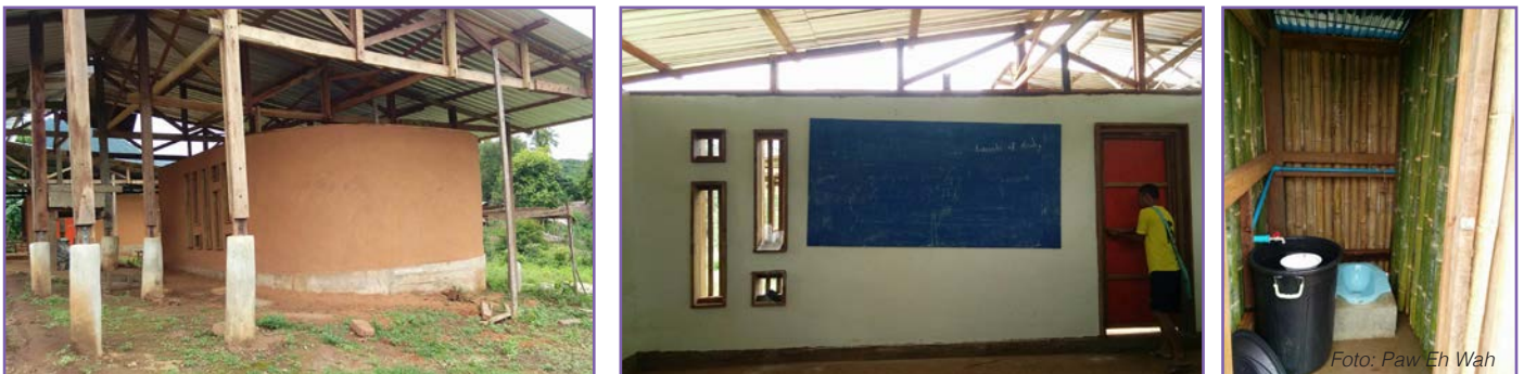
Gaw La Heh Primaryschool. Klasserom 3 og 4 av totalt 6. Taket er sammenhengende for alle de 6 klasserommene. Vi har også laget toalett til skolen. Standarden kan virke primitiv, men dette er toaletter tilpasset lokal bruk og vedlikehold.
